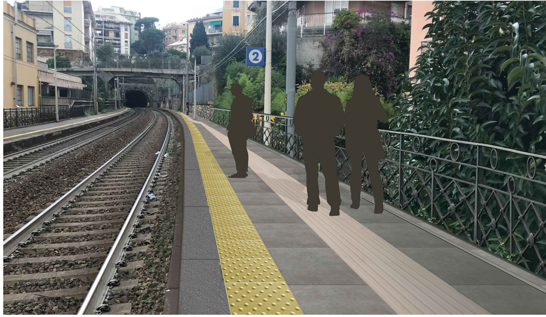
MARCIAPIEDI 2° BINARIO - PROGETTO LARGHEZZA MARCIAPIEDI ADEGUATA: NESSUN PERICOLO PER VIAGGIATORI ALTEZZA MARCIAPIEDE +55 RISPETTO AI BINARI. ACCESSO ALLE CARROZZE A LIVELLO
