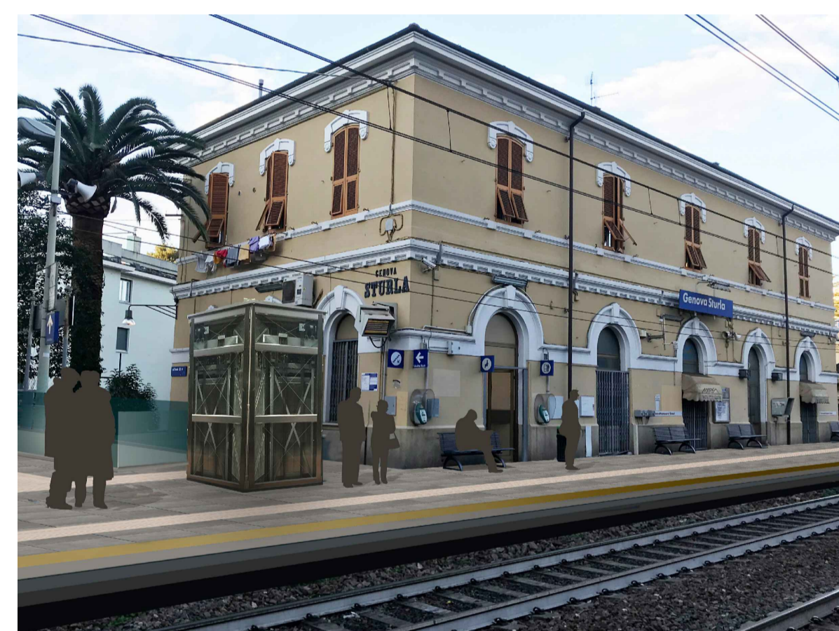
MARCIAPIEDE 1° BINARIO - PROGETTO ASCENSORE PER ACCESSIBILITÀ 2° MARCIAPIEDE H.MARCIAPIEDE +25cm RISPETTO AI BINARI. DIFFICOLTÀ DI ACCESSO ALLE CARROZZE
